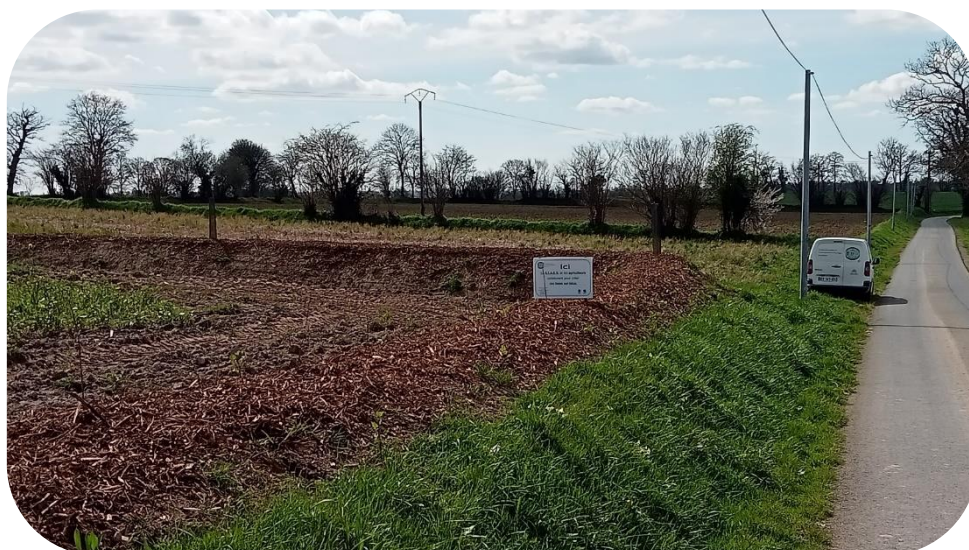
Panneau d'information installé sur un talus en fin de chantier, commune du Chefresne. (SIAES, Mars 2023)
